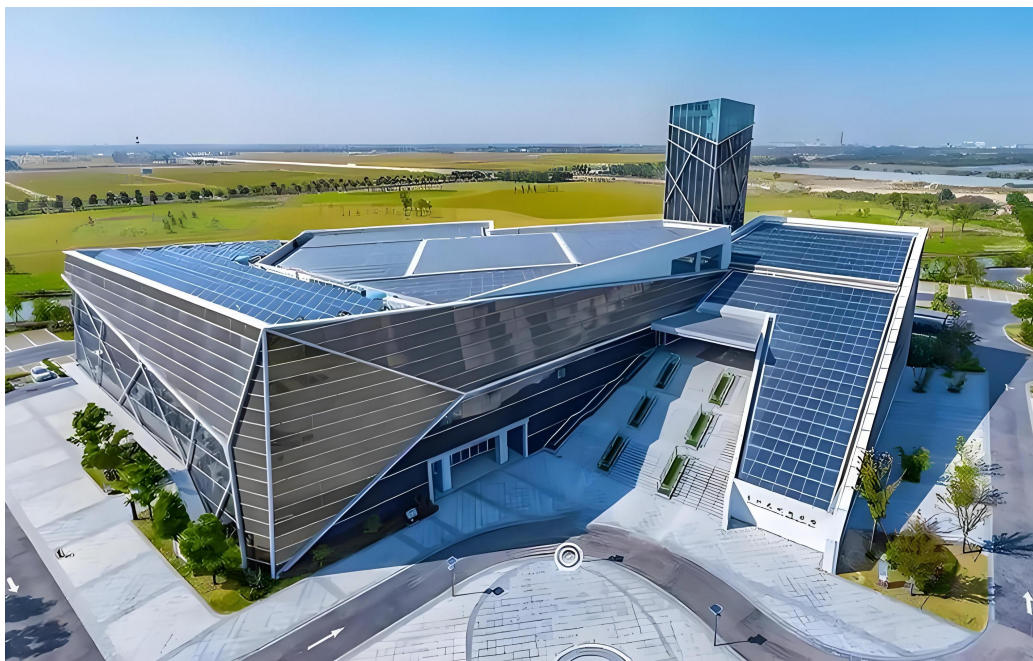
BIPV建筑一体化光伏
